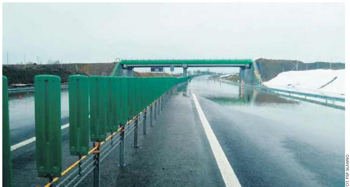
Zalane było ponad 200 metrów drogi w rejonie węzła Sławno Zachód
