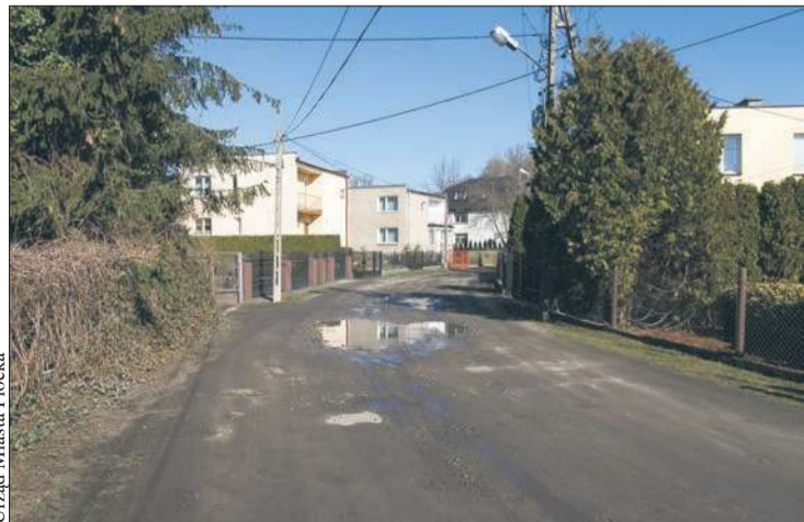
Trwają przygotowania do przebudowy ulicy Zakole
