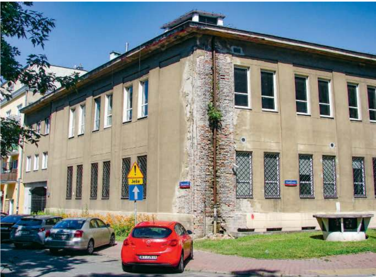
Budynek przy ul. Opaczewskiej 30/Dobosza 1 i fragment rozpadającej się ściany zabytku | fot. Janusz Sujecki/Gazeta Polska
