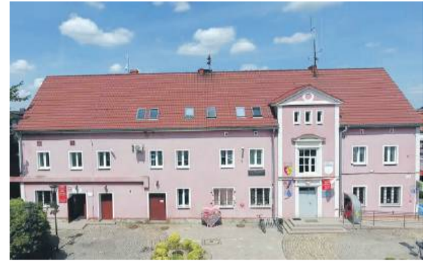
Gmina Kondratowice stara się o dofinansowanie do termomodernizacji budynku urzędu
