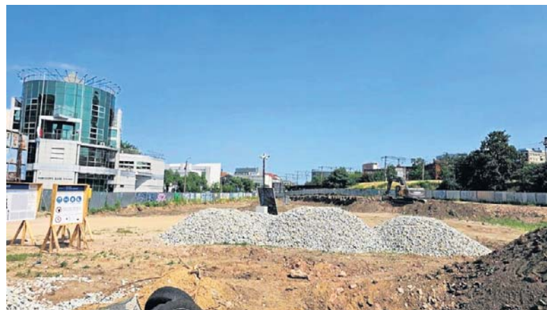
Na działce pracuje koparka, wykonywane są pierwsze wykopy
