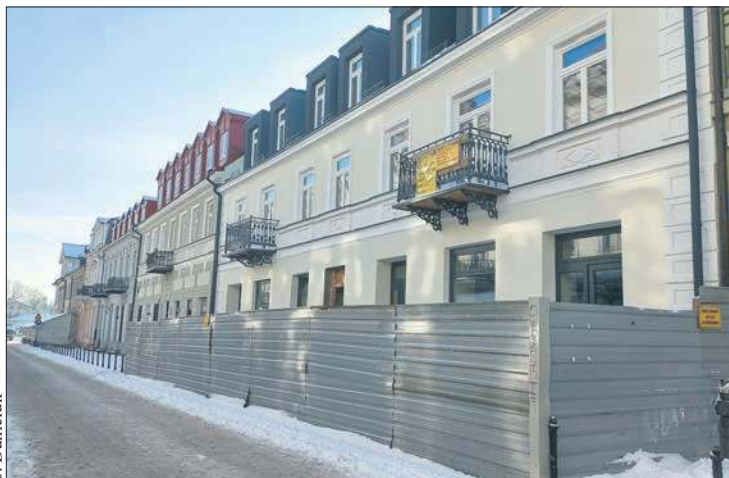
Przebudowywana kamienica przy ul. Grodzkiej 8
