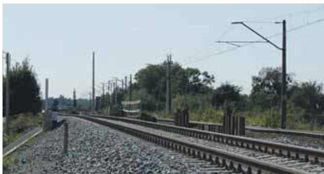
Jeżeli chodzi o wiadukt kolejowy na ul. Zejera, za nami jest część prac pod jednym torem, teraz prowadzone są roboty przy drugim
