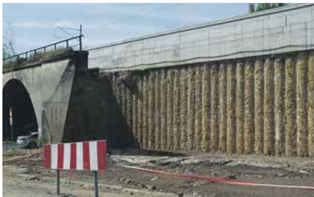
Trwa budowa peronów na przystanku Radzionków Rojca i dojazdu do nich. Budowany jest też wiadukt kolejowy nad ul. Kuźaja ZDJĘCIA: AGNIESZKA RECZKIN
