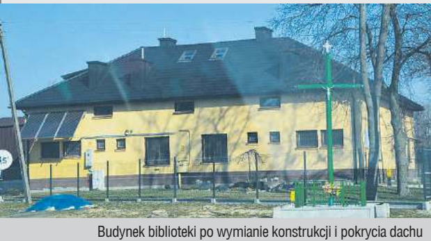
Budynek biblioteki po wymianie konstrukcji i pokrycia dachu
