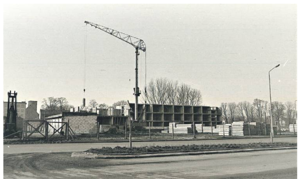
Zdjęcie zrobiłem w 1974 - ul.3 Maja, budowa Hotelu Robotniczego, dziś jest tu Starostwo Powiatowe
