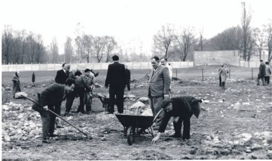
Zdjęcie zrobione w pobliżu ul. Sportowej. Na pierwszym planie mieszkańcy w czynie społecznym sprzątają teren. W głębi ogrodzenie Stadionu Miejskiego i kulochwyt betonowy - według niektórych w tym miejscu w czasie wojny była strzelnica
