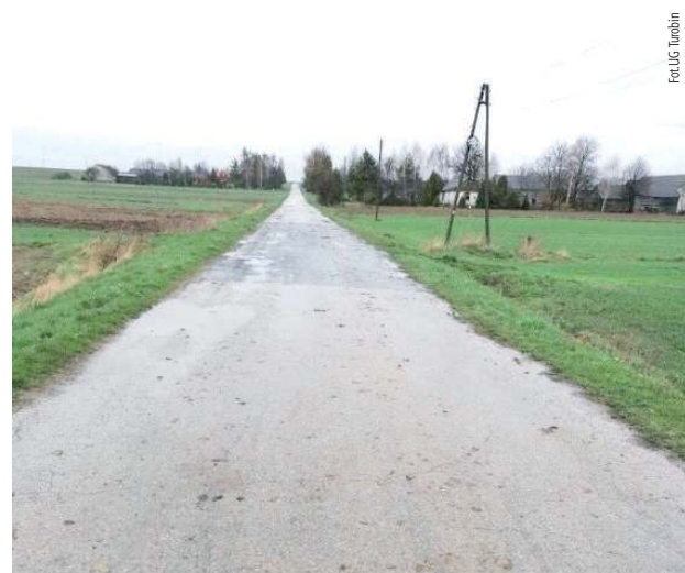
Droga w Czernięcinie Poduchownym: wkrótce czeka ją remont. Termin realizacji to 8 września tego roku, a koszt inwestycji to ponad 350 tys. zł
