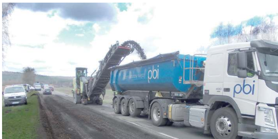
Najpierw frezowanie starej nawierzchni, potem czas na nowy dywanik
