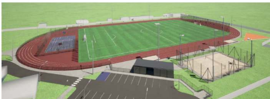
Tak pod koniec sierpnia 2023 mają wyglądać obiekty Zespół Szkół Budowlanych i Ogólnokształcących w Biłgoraju
