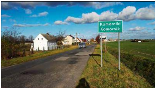
Kolejne zimy odsłaniają fatalny stan drogi, który drogowcy usiłują ukryć pod licznymi łatanami.
