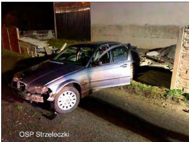
Delikwent rozwalił betonowe ogrodzenie.
