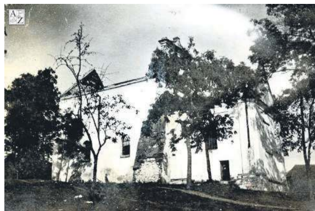
Cerkiew w Szczeszczynie po zburzeniu dachu w 1938 roku. Ze zbiorów APZ
