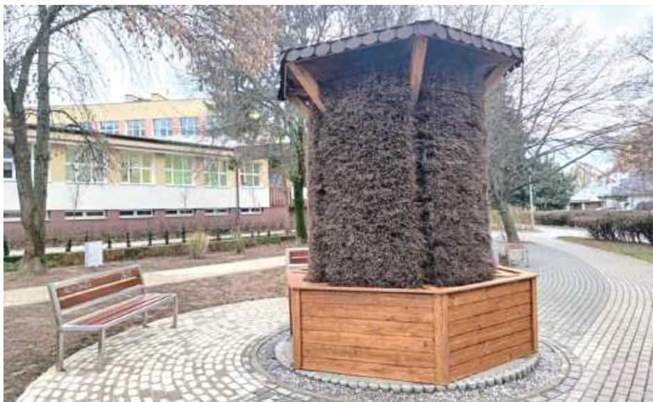
Tężnia stanęła w sąsiedztwie Szkoły Podstawowej nr 11 w Puławach. To już drugie tego typu urządzenie w mieście. Pierwszą tężnię wybudowano w 2019 r. przy ul. Polnej
