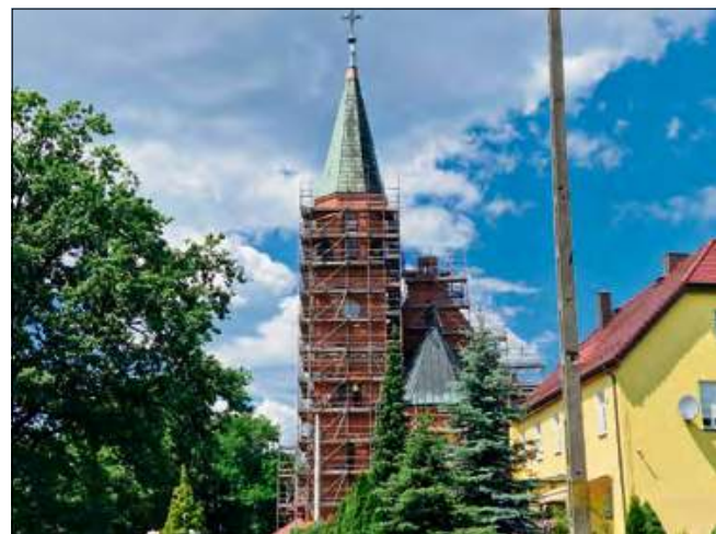
Prace związane z renowacją elewacji mają się zakończyć w sierpniu.
