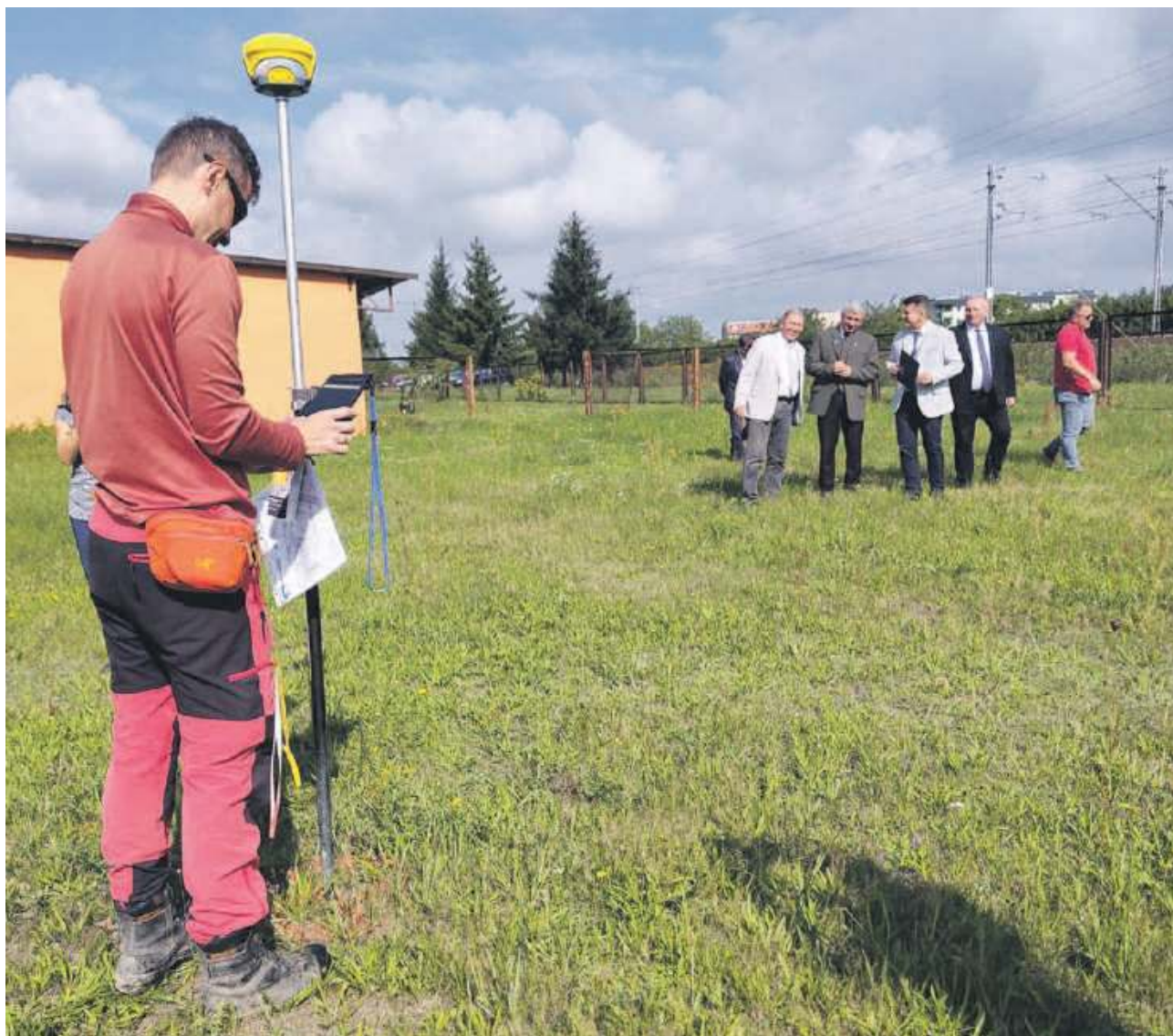
Tego samego dnia geodeta wyznaczył miejsce odwiertu na terenie Miejskiego Zakładu Energetyki Ciepłej w Oławie
