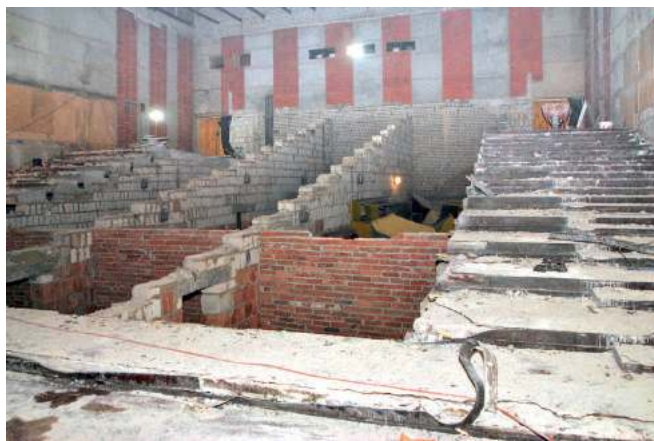
Trwa remont kina i sali widowiskowej w Miejskim Ośrodku Kultury w Międzyrzecu Podlaskim
