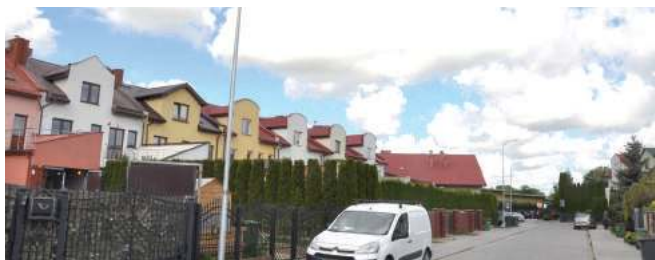
Na ulicy bocznej Bazarowej w Łęcznej wykonano instalację wraz z linią kablową i zamontowano trzy lampy oświetleniowe. Inwestycja została zrealizowana w ramach budżetu osiedlowego na rok 2020. Jej koszt to 37 tysięcy złotych
