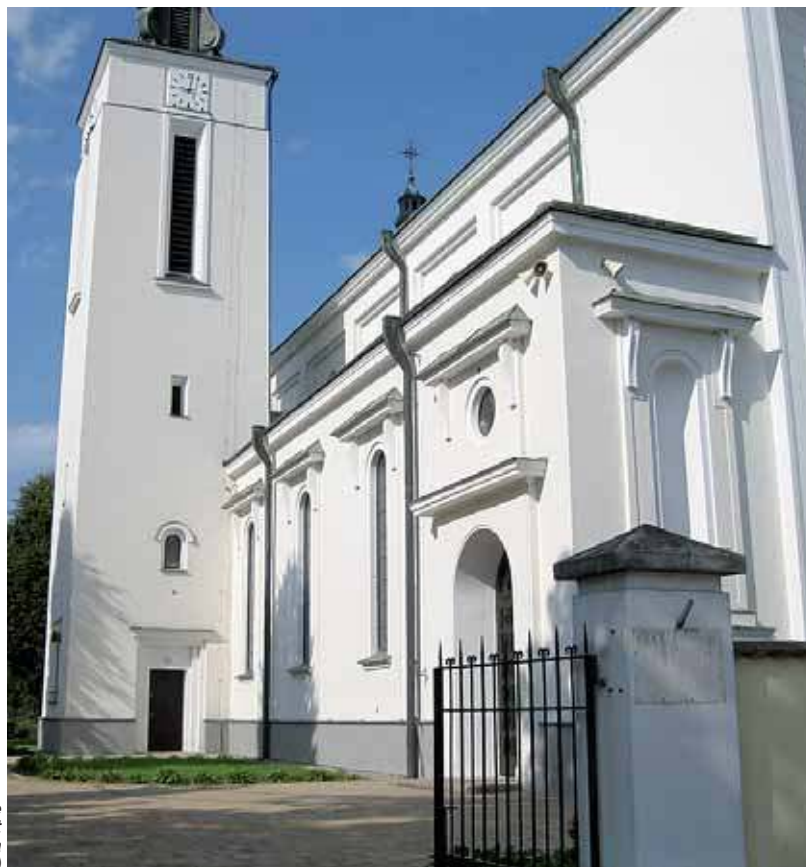
Parafia w Jabłonnicy wykonała remont elewacji kościoła (fot. arch. UMWM)
