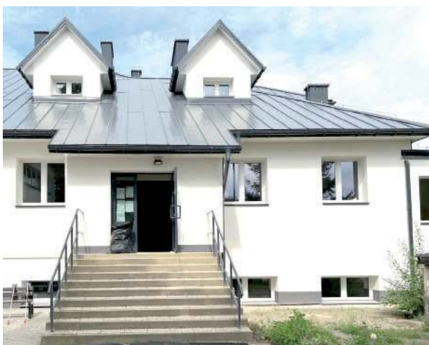
W ramach wykonywanych prac został ocieplony środkowy segment szkoły
