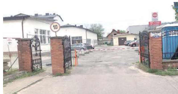
Droga przy szkole muzycznej zakończona jest szlabanem, za którym znajduje się teren RCEZ i plac budowy
