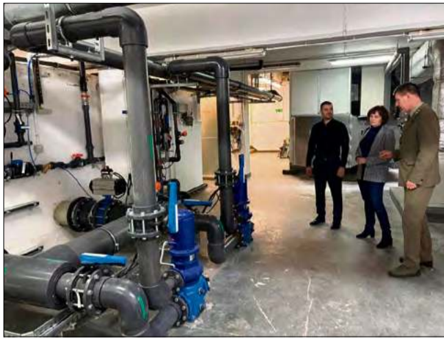
Wicestarosta Leonarda Płoszaj oraz członek Zarządu Powiatu Opolskiego Bartosz Wajman podczas wizytacji nowej stacji uzdatniania wody na modernizowanym basenie w Zespole Szkół w Tułowicach.
