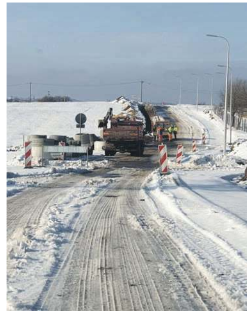
Trwa budowa drogi prowadzącej w stronę zamku w Rudnie
