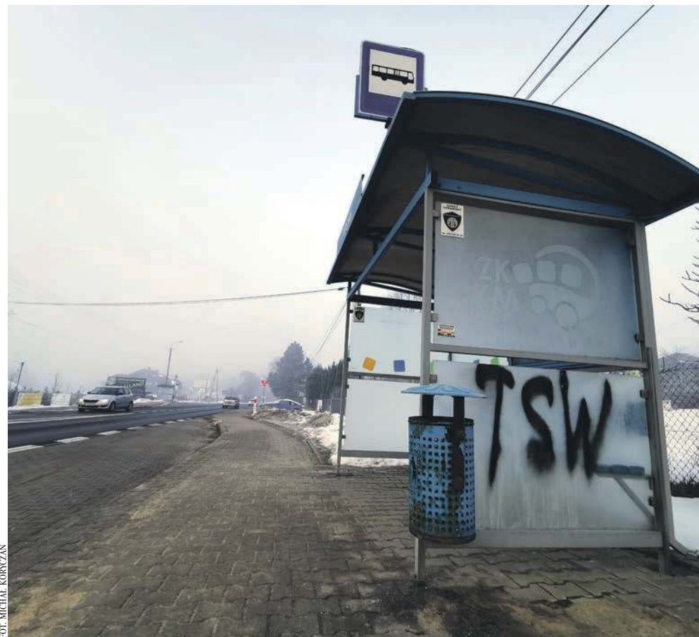
Przystanek autobusowy w Dulowej
