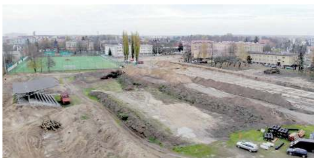
Wykonawca stadionu zapewnia, że wszystkie prace idą zgodnie z harmonogramem
