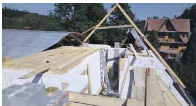
Przy budowie domu dla Świderków brakuje rąk do pracy.
