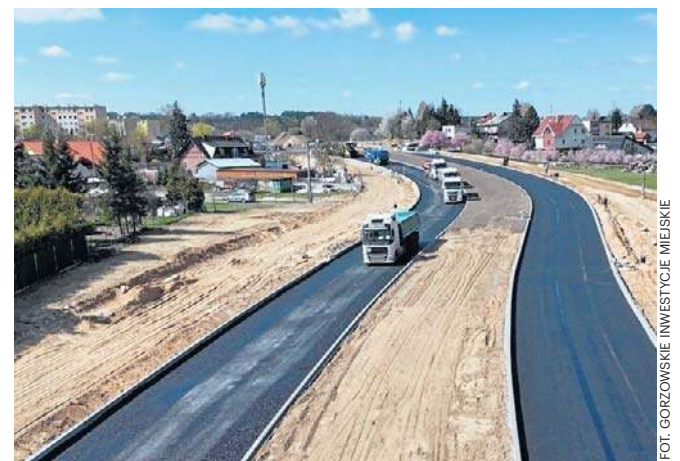
Układanie asfaltu na pierwszym odcinku obwodnicy ma potrwać łącznie trzy tygodnie
