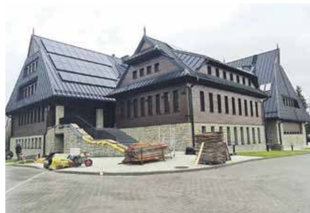
Dom Podhalański po renowacji i rozbudowie robi wrażenie. Będzie się tu mieścić Instytut Dziedzictwa Niematerialnego Ludów Karpackich.
