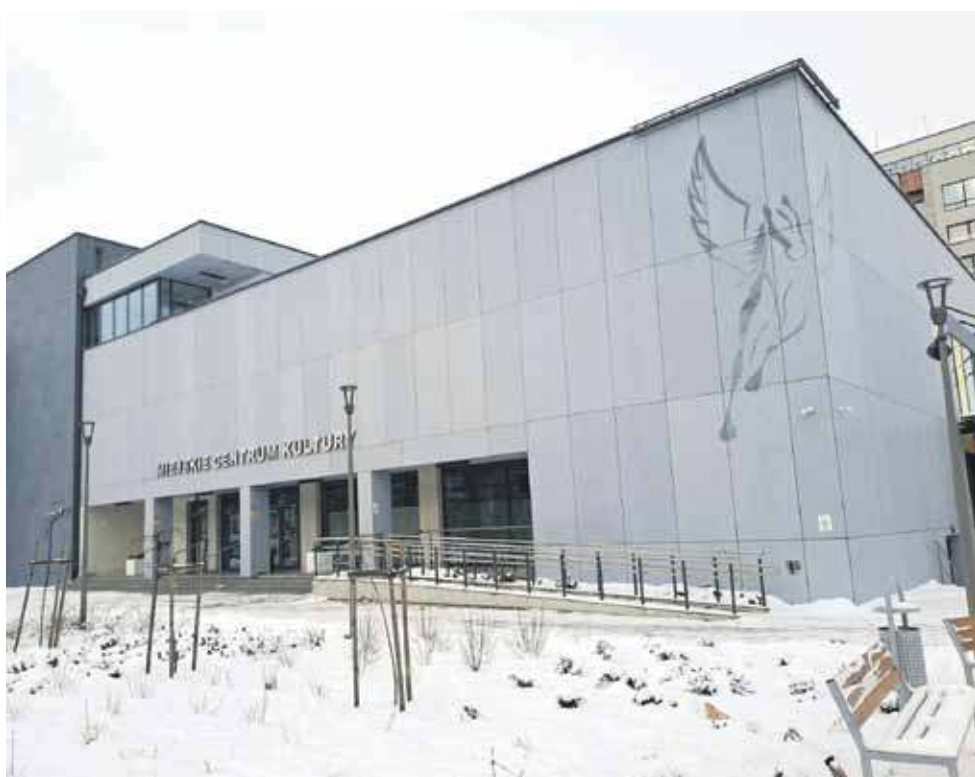
Czy budynek MCK już wymaga remontu?
