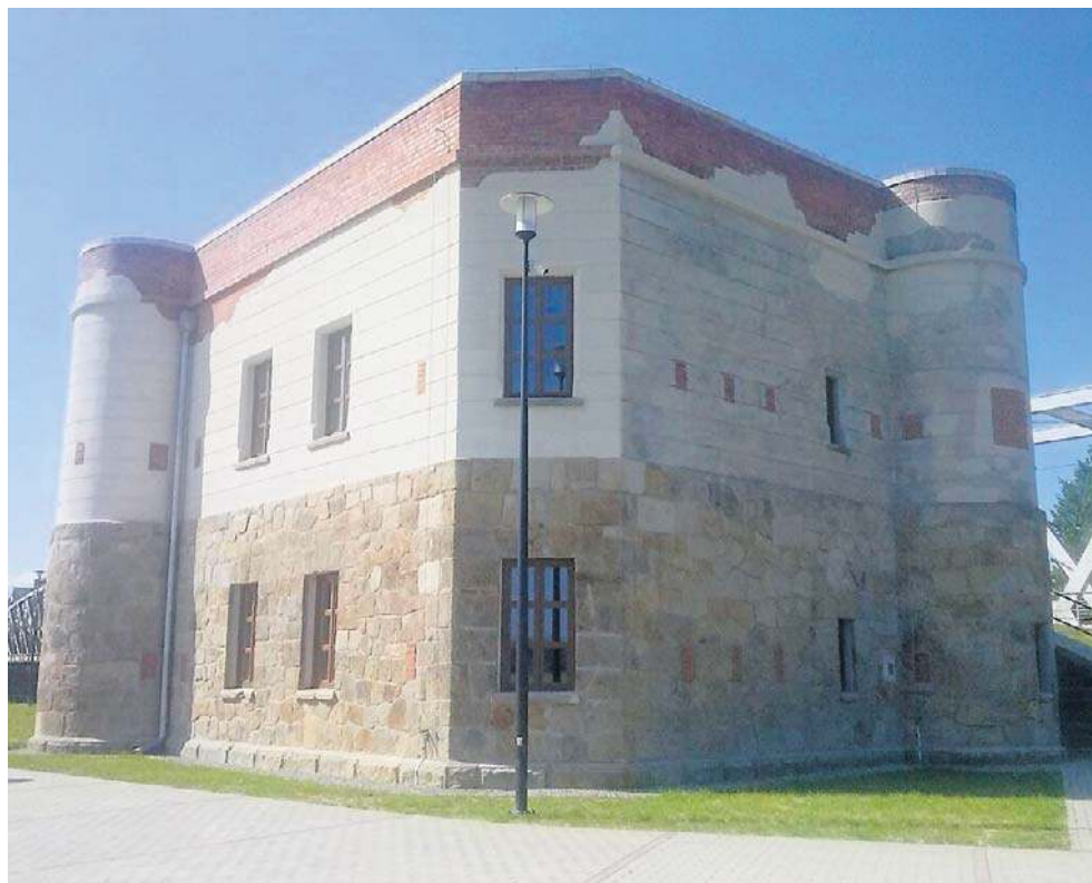
Strażnica kolejowa przy stacji Tryńcza to wyjątkowy zabytek. Po odnowieniu można ją zwiedzać
