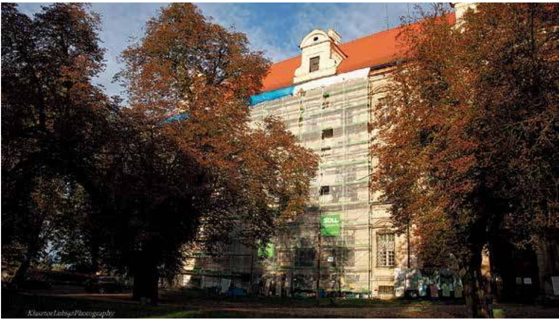
Remont elewacji Klasztoru w Lubiążu
