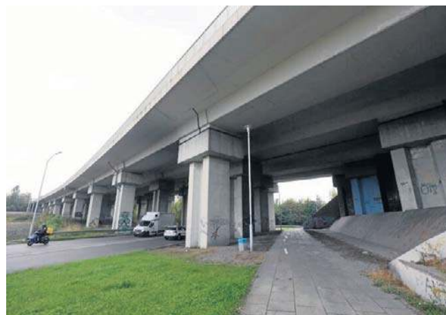
Kierowcy, przygotujcie się. Wiadukt na DTŚ musi przejść remont. Będą utrudnienia
