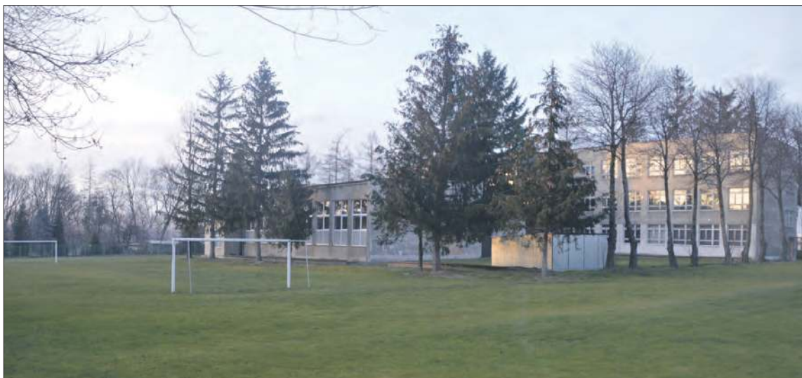
Samorząd powiatowy zastanawia się nad sposobami zagospodarowania budynku przy ul. Podgórznej w Prudniku
