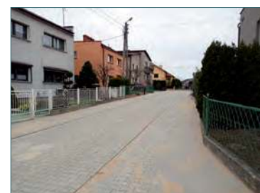
Wyremontowana ul. Reymonta w Prudniku
