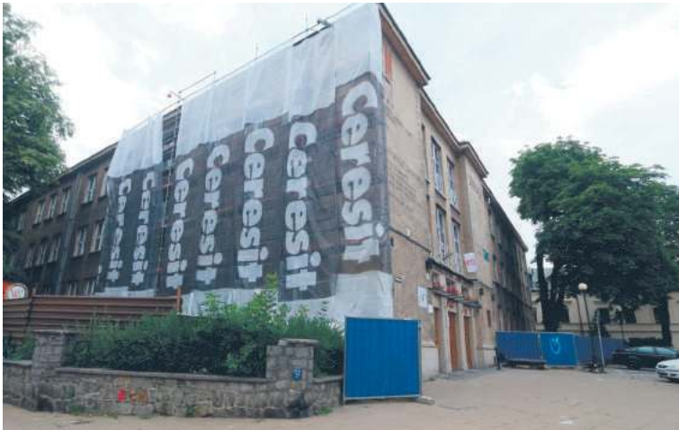
Rozpoczęta teraz termomodernizacja III LO im. Unii Lubelskiej potrwać może aż do przyszłorocznych wakacji
