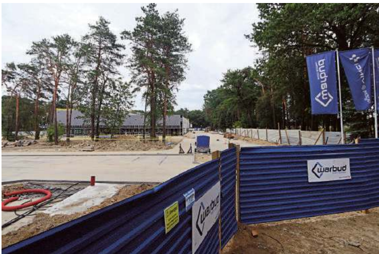
Główny pawilon basenowy jest już w stanie surowym
