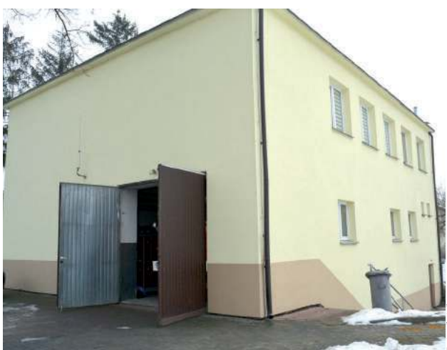
Zgodnie z projektem nowy garaż ma być dobudowany do tylnej ściany remizy przy ul. Włostowickiej
