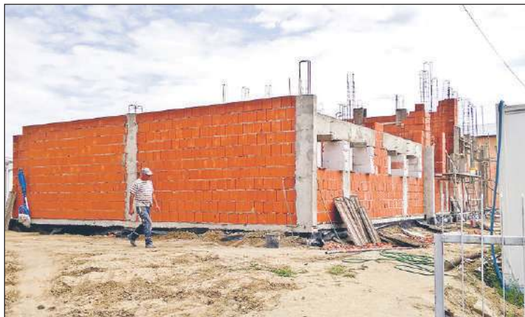
Nowe garaże budowane są za budynkiem dębickiej komendy.
