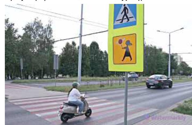
Duży, podwójny znak i biało-czerwone oznakowanie poziome na przejściu na Czubach. To przejście jest oznakowane znacznie lepiej
