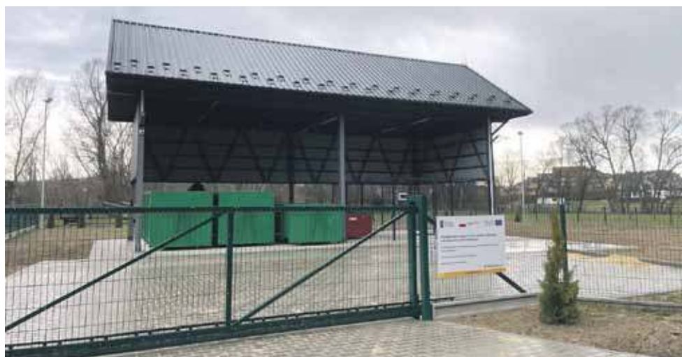
Instalacja powstała w sąsiedztwie oczyszczalni ścieków.
