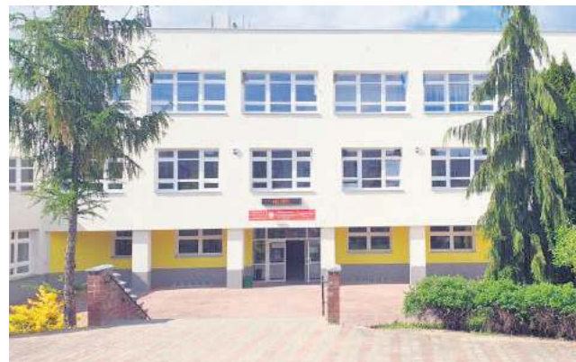
Budynek ZSP nr 3 po termomodernizacji.
