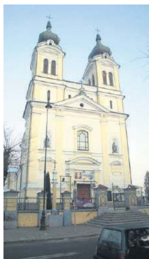
Parafia pw. Trójcy Świętej i Wniebowzięcia NMP w Biłgoraju chce przebudować ogrodzenie kościoła.
