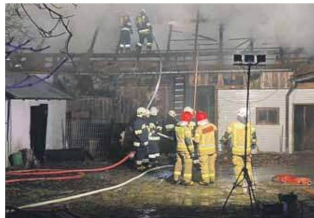
Spłonął niemal cały dach budynku gospodarczego.
