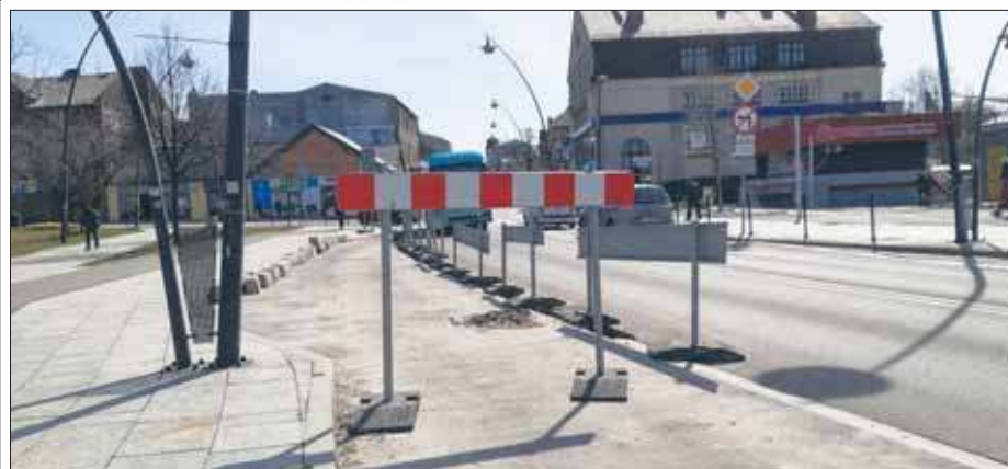
Rynek odNowa i centrum przesiadkowe też odNowa
