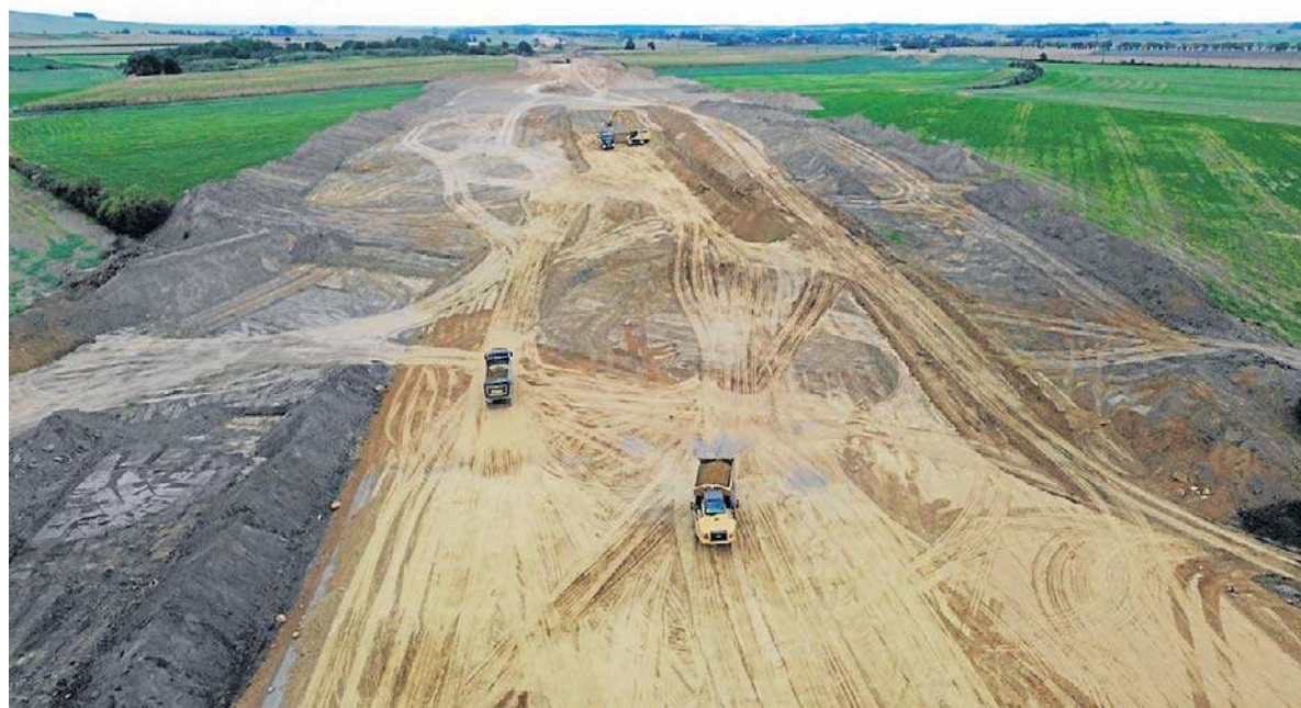
Tak powstaje S8 na odcinku Jordanów Śląski - Łagiewniki. Prace ziemne idą pełną parą
