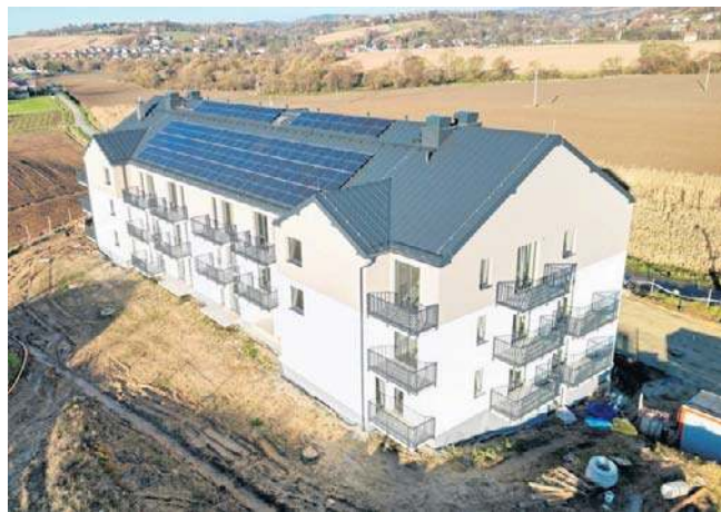
Budowa bloku w Siedliskach jest już na ostatniej prostej. Do wzięcia są jeszcze dwa mieszkania
