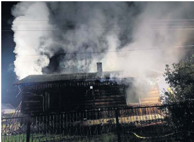
W nocy z niedzieli na poniedziałek 5 października strażacy gasili pożar domu drewnianego w Głuszynie.
