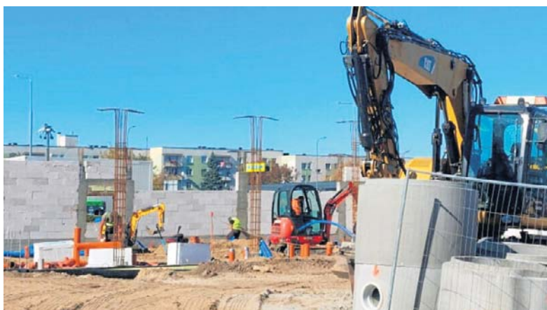
Trwa budowa nowej restauracji McDonald's przy ulicy Mieszka I na Michałowie w Radomiu, mury już pną się do góry.
