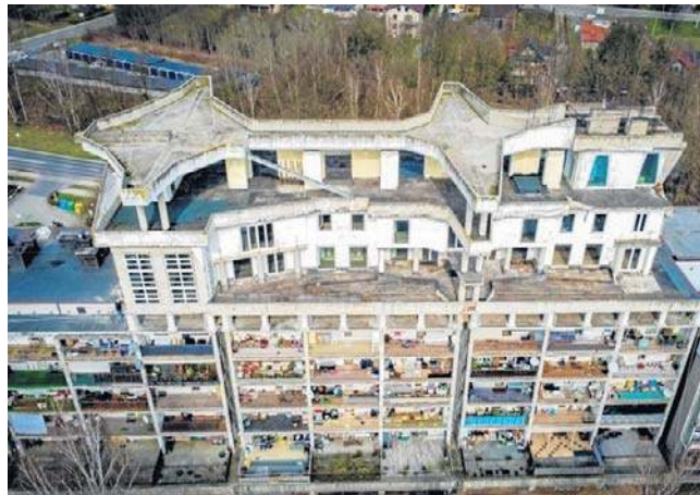
Faktyczna rozbiórka słynnej nadbudowy przy Północnej 4 ruszyła w połowie maja 2024 roku
