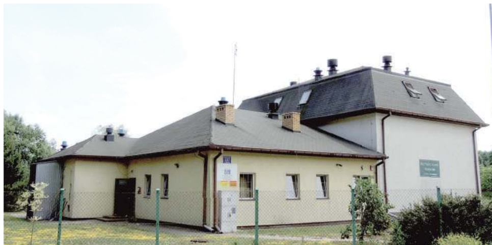
Oczyszczalnia w Karczmiskach jest oczyszczalnią typu biologicznego. Trafiają do niej ścieki bytowe, wytworzone przez mieszkańców
