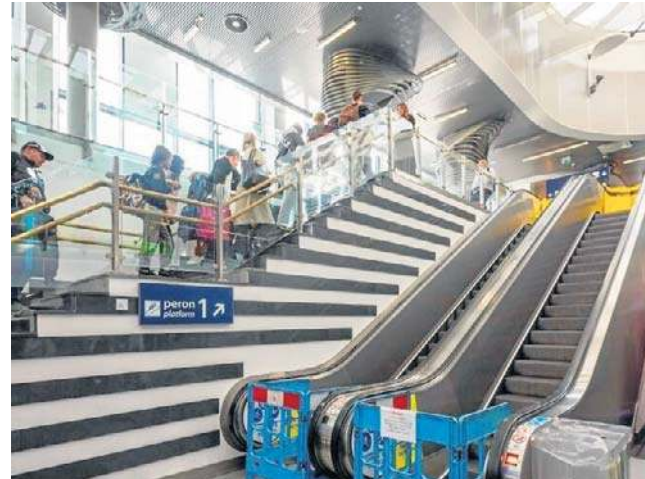
Ruchome schody na dworcu PKP Bydgoszcz Główna oczekują na wymianę łańcuchów i poręczy
