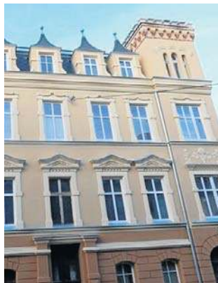
Renowacja elewacji frontowej kamienicy przy ulicy Nakiełskiej 4 kosztowała ponad 300 000 złotych
