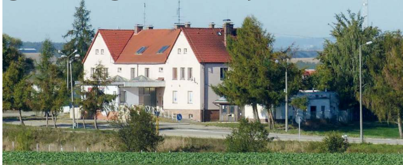
■ Obiekt mieści się na przy drodze wojewódzkiej nr 916 na trasie Racibórz – Pietraszyn, w kierunku: Sudice – Opawa – Ołomuniec FOT. UM KRZANOWICE
