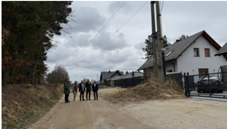
Ulica Akacyjowa przed remontem.
