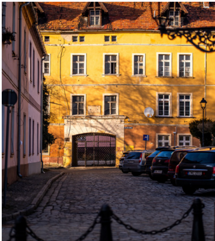
Aktualny stan obiektu.
