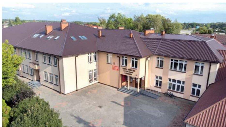
Rozbudowa i przebudowa budynku Zespołu Szkół Nr 3 w Łukowie
