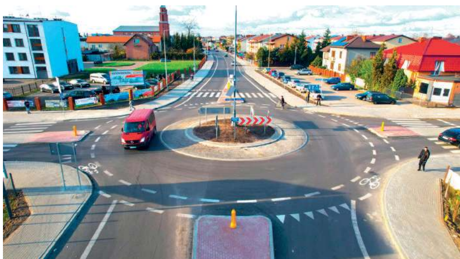
Zmodernizowana ul. Popietuski w Łukowie-droga powiatowa
