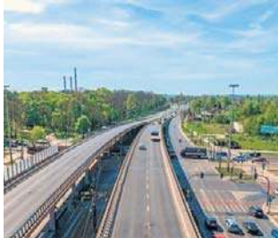
Estakada przy Dworcu Kaliskim ma pół kilometra
