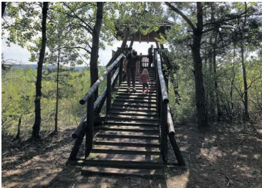
Najdalej położony punkt widokowy przypomina niewielką wieżę widokową
