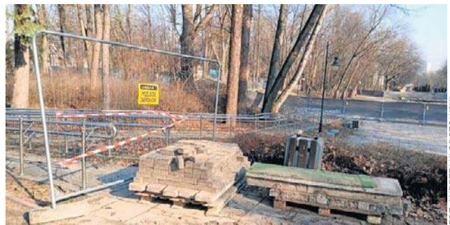
Tak wygląda obecnie przebudowywana Aleja Zakochanych
